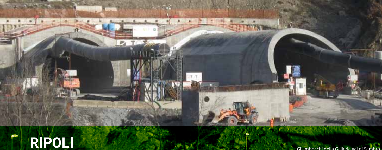
Gli imbocchi della Galleria Val di Sambro
